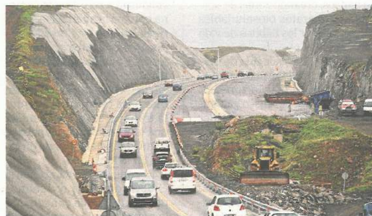
Imagen de archivo de trabajos en la GC-3, en Arucas. JUAN CARLOS ALONSO
